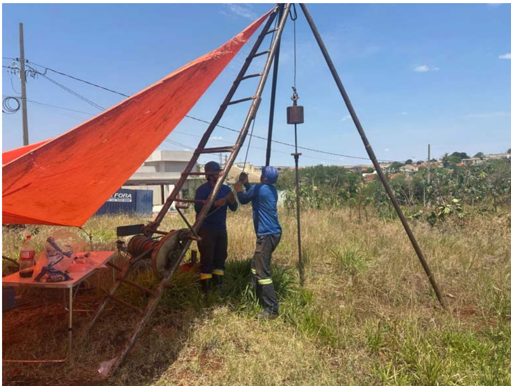
Foto 03 – Perfuração do furo SP-02. Foto Alexandre.
