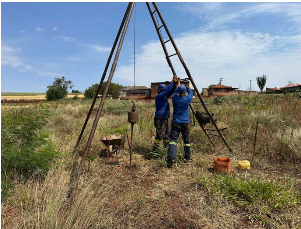
Foto 01 – Perfuração do furo SP-01. Foto Alexandre.
